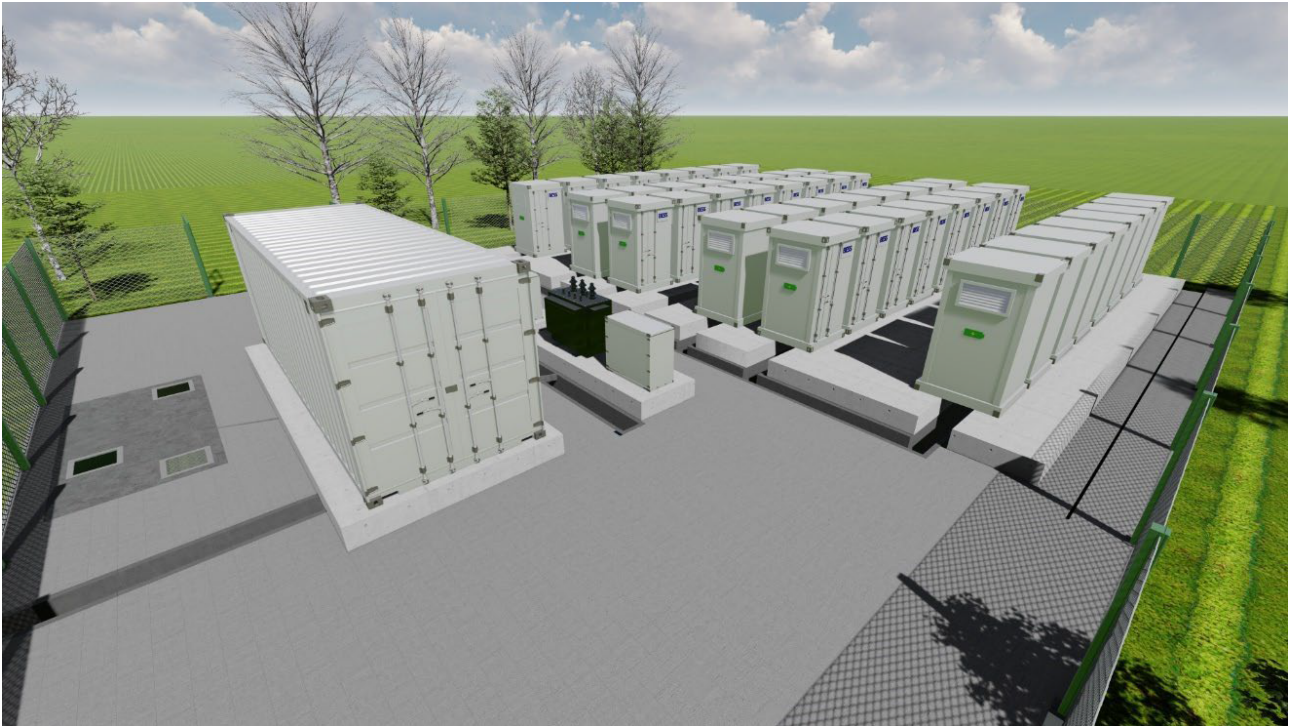
Figur 5: Eksempel på Batterianlæg på 20 MWh. Kilde: GreenGo Energy
