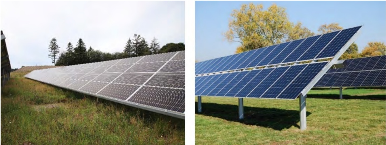
Billede 2-2 Eksempel på solcellepaneler monteret på faste stativer (til venstre) og monteret på stativer med trackersystem (til højre)
