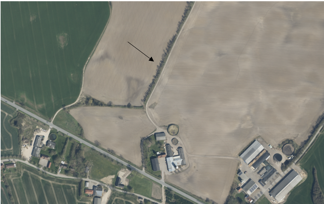
Figur 11-6: Sten- og jorddige nord for Sommerstedvej, mod plan- og projektområdets sydøstlige afgrænsning. Kilde: Klimadastyrelsens skråfoto.
